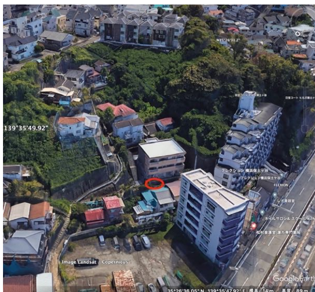
図2. 斜面崩壊箇所(Google Earth)
