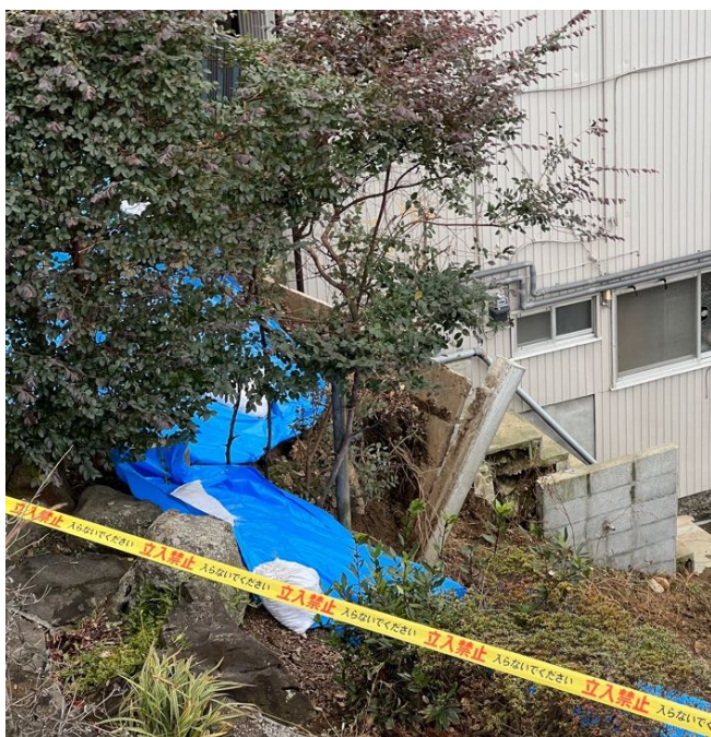
図 9. コンクリート土留め板を上位から撮影。
