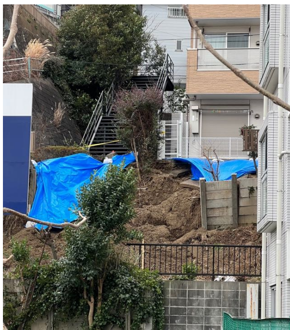
図 10. 土砂崩れ地点を道路側（北西）から撮影。
